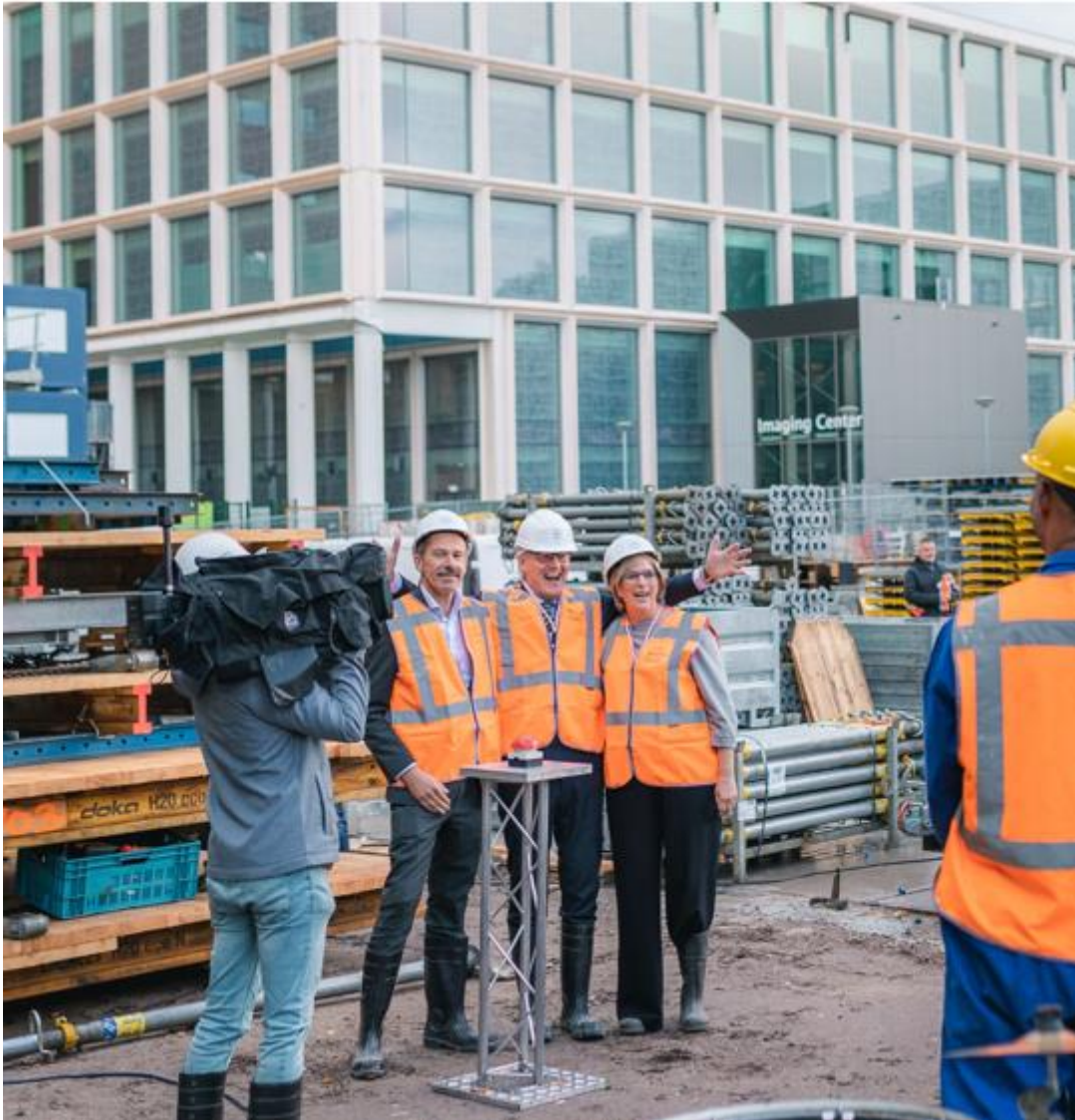
Chris Polman (voorzitter Raad van Bestuur Amsterdam UMC), Geert Kazemier (oncolologisch chirurg en initiatiefnemer van ADORE) en Marianne van der Bent (projectleider directie Vastgoed) geven het startsein voor de feestelijke start van de bouw
